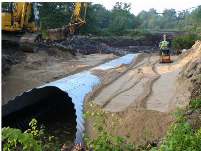
Fotos viser etablering af nyt stålør august 2010 og foto til højre viser tidligere vejoverkørsel ved Huulmøllevej.
